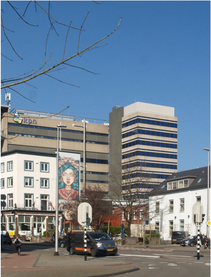
Het KPN-gebouw in de spoorhoek
